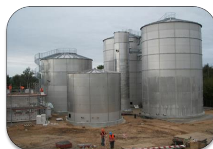
Silosy i zbiorniki
